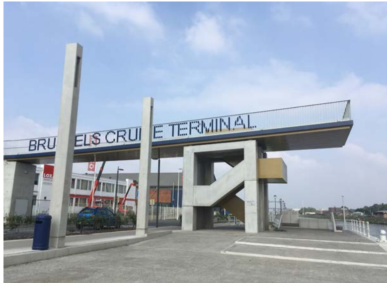
Brussels Cruise Terminal – Voorhaven, linkeroever
