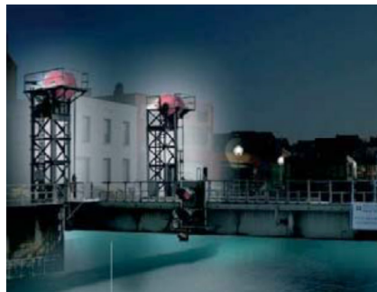
Verlichting van de Godshuizenbrug
